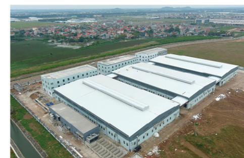
越南河南金箭科技营造一期项目
