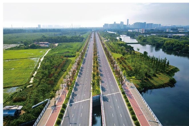
南天成路西延景观工程
