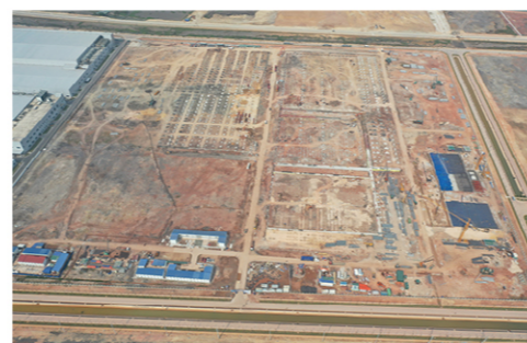
越南晶科太阳能光伏工艺项目
