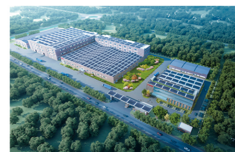
越南先进膜材有限公司新建厂房项目建安工程
