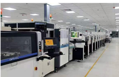
易德龙越南工厂装修项目
